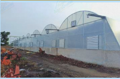
FAN PAD GREEN HOUSE
