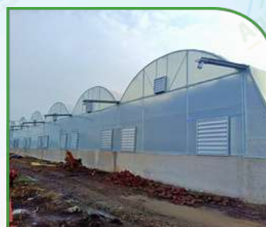
Fan Pad Polyhouse - FPPH
