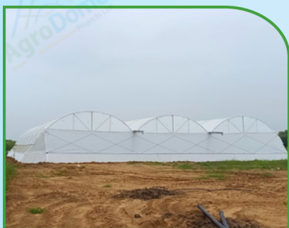
Dome Roof Poly Net House -DRPNH
