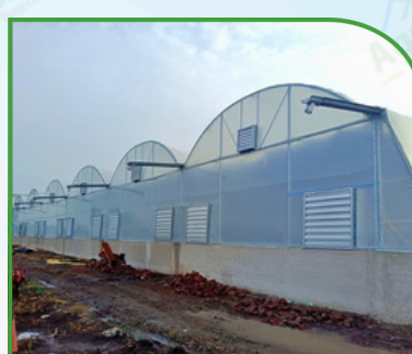
Fan Pad Polyhouse - FPPH
